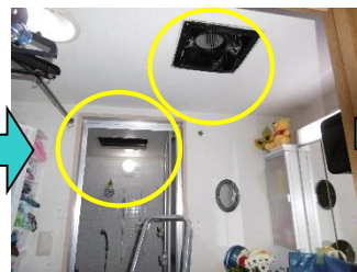
III / バス・洗面所等の点検口内ダクトの配置確認
