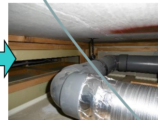
III / バス・洗面所等の点検口内ダクトの配置確認
