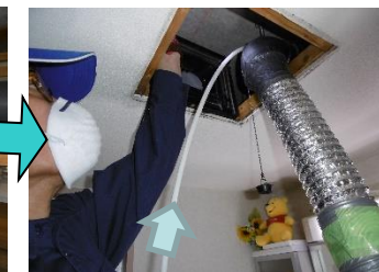
V / 換気ダクトに吸塵ホースを取付、エアコンプレッサーのビードイング振動によってダクト内の汚れをたたき、剥がし、浮かせて高圧吸塵機にて集塵します。
