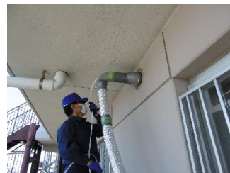
VI / 屋外側、排気口からも高圧吸塵機にて除塵
